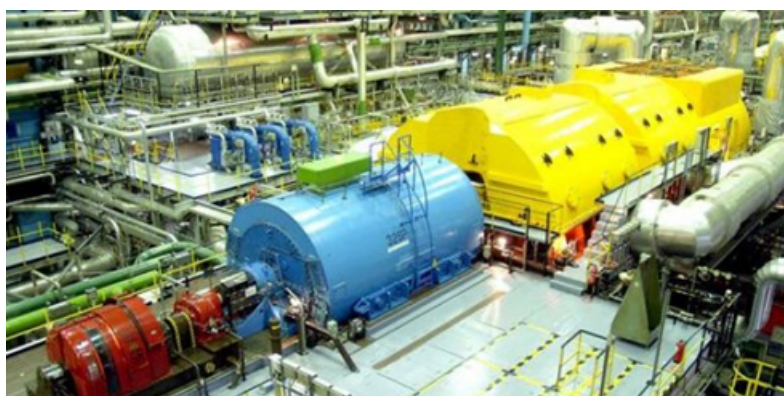
7.2. ábra. A turbina és a generátor: Sárga: turbinaház; Kék: generátor; Piros: gerjesztőgép [Bacsikai P. foto 2]
