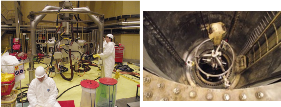
5.22. ábra. Balra vizsgálóberendezés előkészítése Pakson ([Trampus]), míg jobbra a behelyezése a kiürített reaktor tartályba
