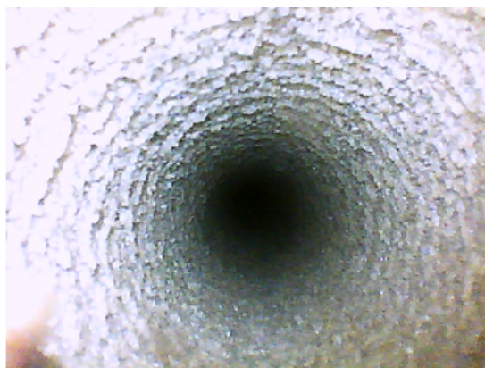
7.4. ábra. Két évet üzemelt hűtőadó cső, karbantartás előtt [Bacsikai P. foto 2]
