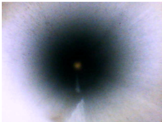
7.5. ábra. Két évet üzemelt hőátadó cső, karbantartás (tisztítás) után [Bacsikai P. foto 2]
